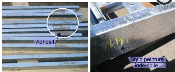
PHOTOS 23 &amp; 24: MARQUAGES AVANT THERMOLAQUAGE
